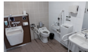
「多目的トイレ」
